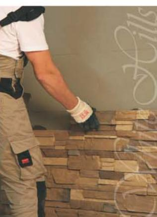
8. Крепко прижмите камень к стене и слегка «подвигайте» из стороны в сторону, чтобы обеспечить наилучшее сцепление. Для монтажа камня с расшивкой используйте чопики для фиксации камня.
