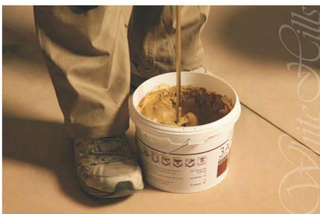
**10.** После полного высыхания клеевого раствора вы можете приступить к **расшивке швов**. Приготовьте затирочный раствор строго в соответствии с инструкцией производителя, указанной на упаковке. Краситель желаемого оттенка добавьте в сухую смесь белой или серой затирки до добавления воды.
