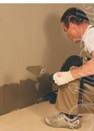
6. Нанесите гладким шпателем клеевой раствор на подготовленную стену. Разровняйте клей зубчатым шпателем.
