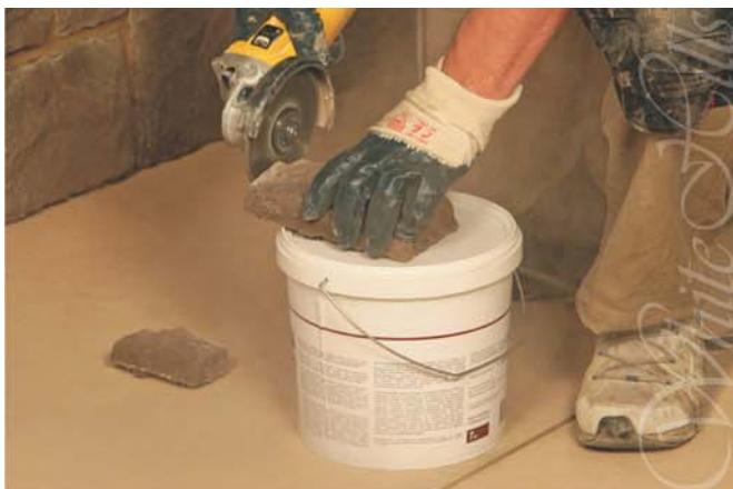
**9.** Камень хорошо поддается механической обработке и, при необходимости, его легко отрезать болгаркой, чтобы придать нужный размер.
