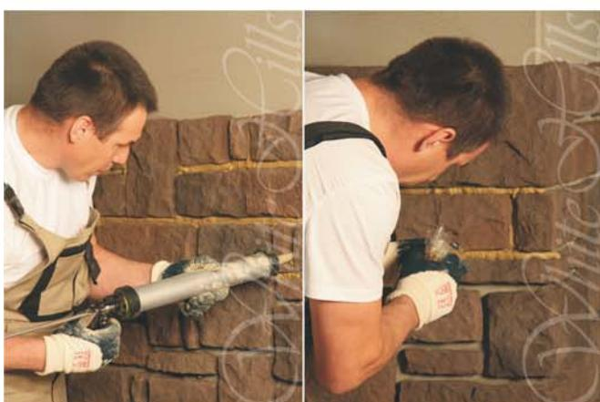
**11.** Заполните швы с помощью строительного шприца-пистолета или специального кулька для затирки, медленно выдавливая затирочный раствор.
