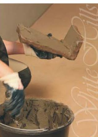
7. Монтаж камня начинайте с угловых элементов. Нанесите клеевой раствор на тыльную поверхность камня, чтобы вся его площадь была равномерно покрыта клеем.
