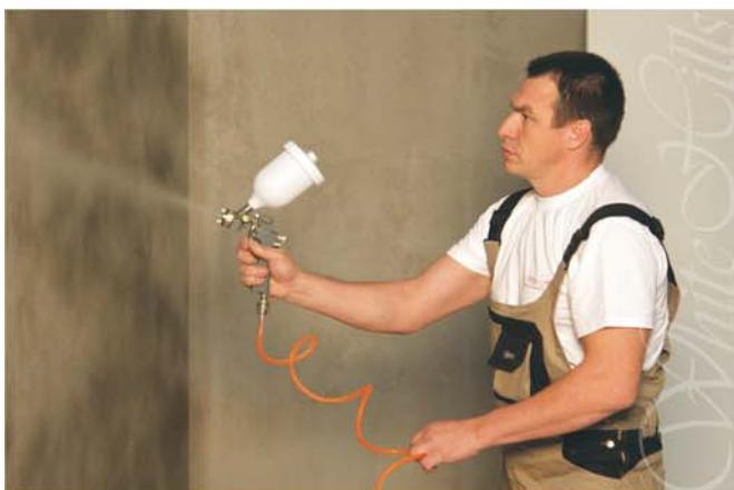
**3. Подготовка поверхности (основания) для укладки.** Основание должно быть прочным, чистым, ровным, не подвергаться усадке или деформации и иметь хорошую адгезию к клеевому составу. Если монтаж ведется в условиях жаркой и сухой погоды, то рабочую поверхность и тыльную сторону камня следует увлажнить.
